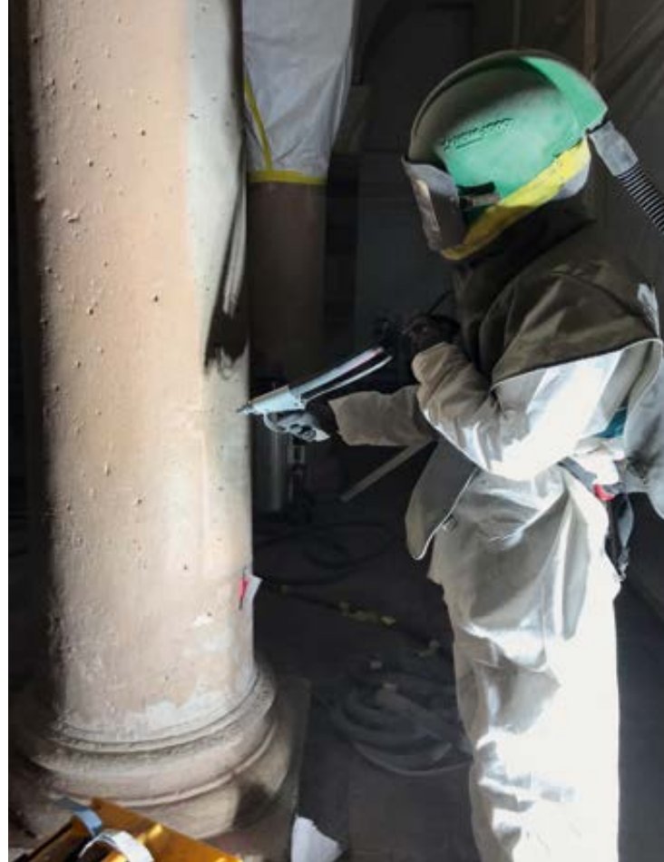
27 Entfernung der Beschichtung auf den Säulen und Basen des Westwerk-Erdgeschosses durch die Restauratorin Peña Moradillo, 2020
