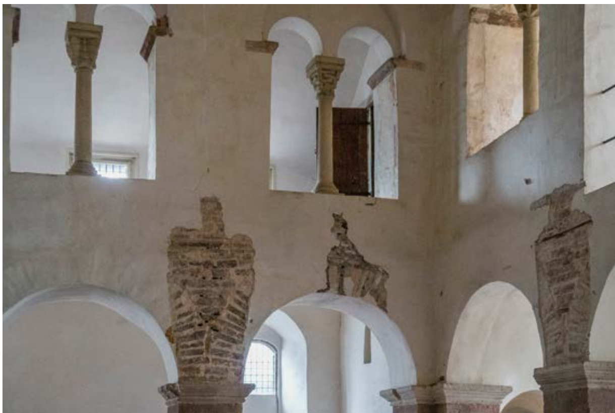
21 Freigelegtes Mauerwerk mit Sinopien
