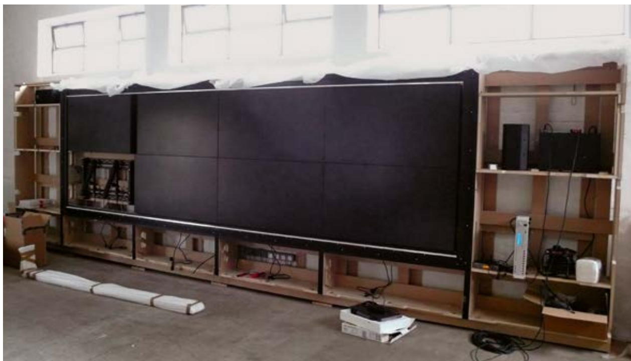
20 Bauansicht der Medienwand im Fagus-Werk, 16. März 2015
