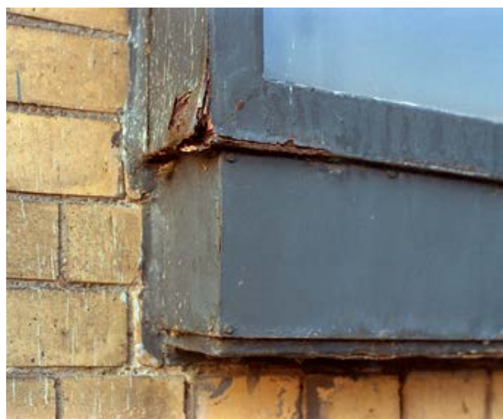
4 Korrosionsschäden an den Fenstern des Hauptgebäudes, Zustand 1984 Corrosion on the windows of the main building, 1984
